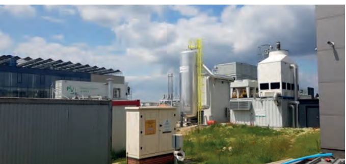
Budowa fabryki wodoru w Klastrze Gaj Oławski
